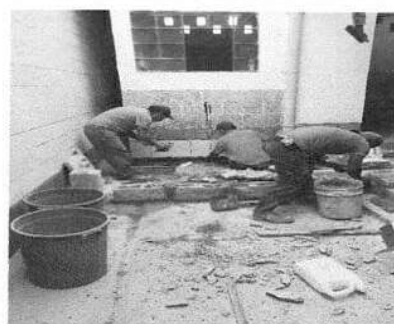
Foto 6: MÓDULO 2: Construcción del lugar de la pila reparada.
