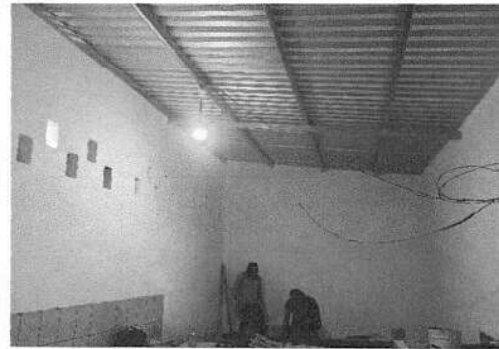
Foto 2: MÓDULO 2: Fotografías donde muestra la preparación y limpieza del área de del poyeton para colcar azulejos en la orilla y la para colocar la campana de metal para desfogar el humo.
