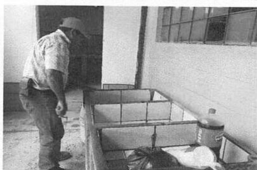
Foto 5: MÓDULO 2: Reparación de la pila, colocando azulejos en su interior
