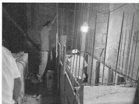
Foto 1: MÓDULO 2: Fotografía inicio de construcción de la nueva pila para la cocina.
