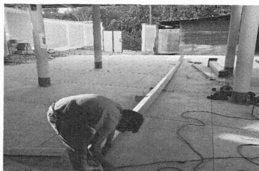
Foto 4: MÓDULO 2: arreglos del canal para instalar en en el entechado de la cocina en la del pasillo de la entrada del baño.
